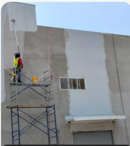
Tratamiento de fachadas
