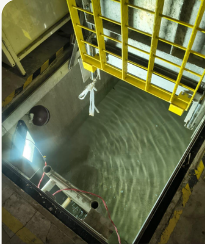
Limpieza de cisternas
